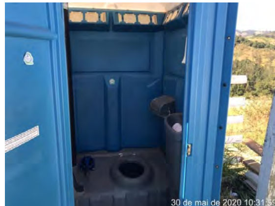
Foto 253 - Limpeza e higienização de banheiro químico no canteiro de obras (Data:30/05/20).
