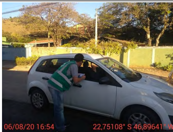
Foto 6 – Apoio no bloqueio de vias para o desmonte de rocha – Rua Padre Francisco Salviato. (06/08/2020)
