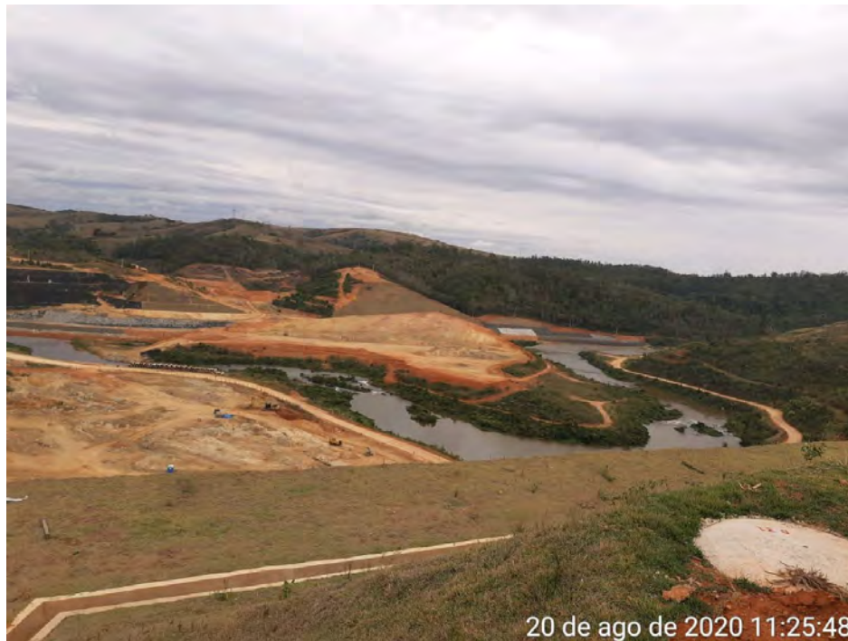
Foto 1 - Vista do trecho do rio Jaguari a ser temporariamente desviado.
