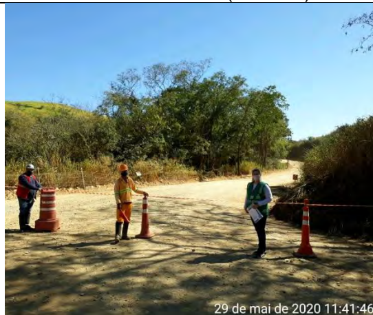
Foto 206 – Apoio no bloqueio da via durante o desmonte de rocha (29/05/20).
