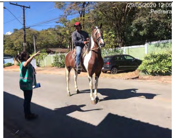
Foto 205 – Apoio no bloqueio da via durante o desmonte de rocha (29/05/20).
