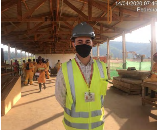
Foto 75 – Máscara distribuída para uso contínuo no canteiro de obras (14/04/20).
