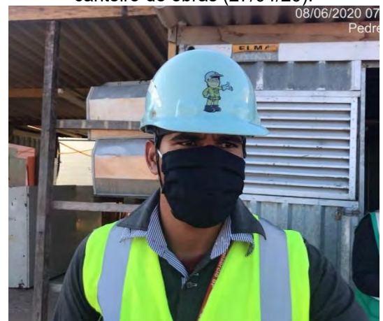
Foto 134 – Uso constante de máscaras no canteiro de obras (08/06/20).
