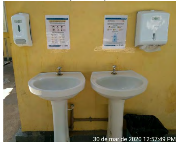
Foto 163 – Cartazes sobre o novo coronavírus pelo canteiro administrativo (30/03/20).
