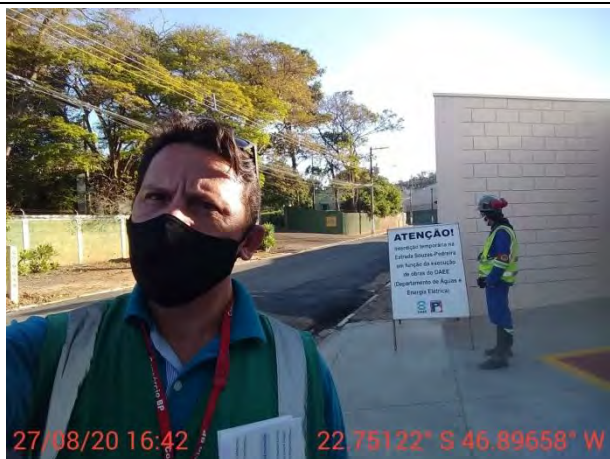
Foto 17 – Apoio no bloqueio de vias para o desmorte de rocha – Rua Padre Francisco Salvino. (27/08/2020)
