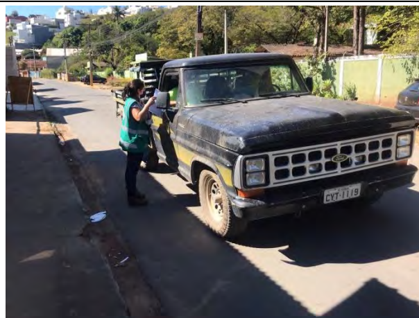
Foto 14 – Apoio no bloqueio de vias para o desmonte de rocha – Rua Padre Francisco Salvino (16/06/2020).
