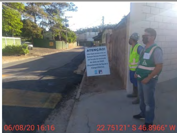
Foto 5 – Apoio no bloqueio de vias para o desmonte de rocha – Rua Padre Francisco Salviato. (06/08/2020)
