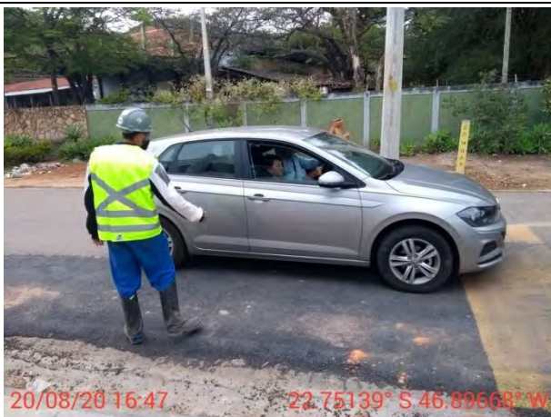
Foto 11 – Apoio no bloqueio de vias para o desmonte de rocha – Rua Padre Francisco Salvino. (20/08/2020)
