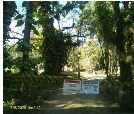
Foto 173 – Cartaz informando o uso obrigatório de máscara dentro do canteiro de obras (07/05/20).
