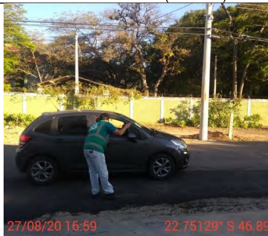
Foto 209 – Apoio no bloqueio da via durante o desmonte de rocha (27/08/2020).
